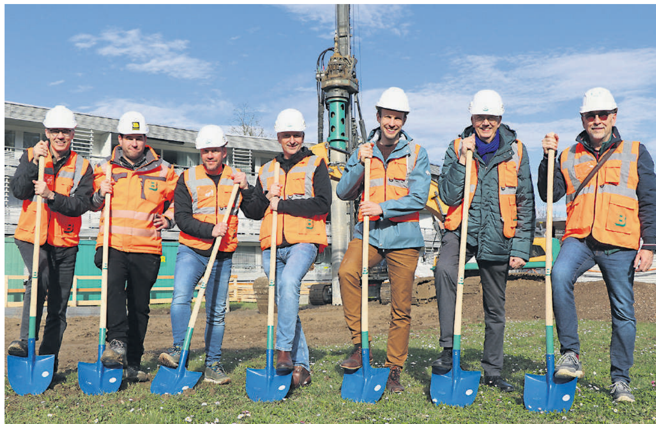
Spatenstich (von links) mit Reto Koch (Geschäftsleiter Otto und Partner), Tobias Kleiner (Bauführer Birchmeier), Thomas Sacher und Patrick Mathis (Wohnbaugenossenschaft), Marco Hoch (Architekt), Werner Schneider (Wohnbaugenossenschaft) und Rolf Müller (Bauleitung).
