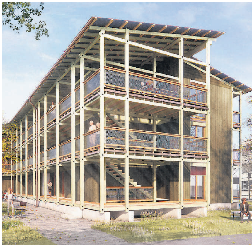
Projekt «Südlaube» mit Holzverkleidung.
